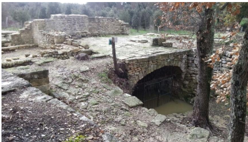
Extrémité Sud du réservoir et voute d'arrivée d'eau, surmontée d'une aire à battre Derrière le mur au fond : la chambre des meules La rampe d'accès au réservoir est très probablement récente.
