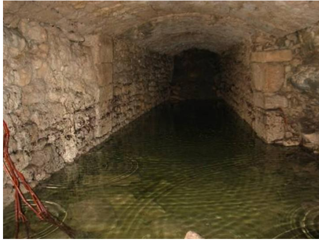
La fuite vue de la chambre des meules, après un épisode pluvieux
