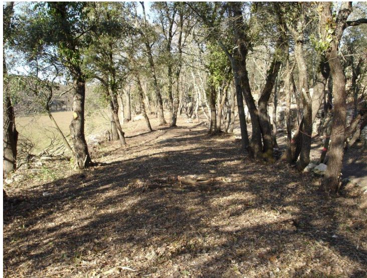
Au centre : la digue A gauche : : les prés en contrebas A droite : le réservoir.
