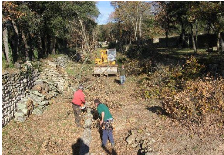
Au centre : le réservoir. A gauche : la digue A droite la terrasse au fond maçonné avec champs au dessus
